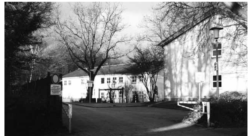
Das Übergangswohnheim an der Wohlfahrtstraße: Um die Hauptgebäude in der Mitte herum ziehen sich weiße Wohn-Container. Foto: In
