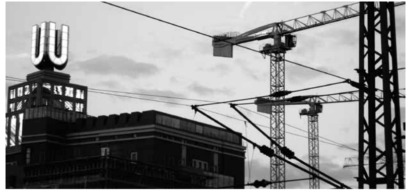
Gebaut wird, aber für wen? Das Manifest „Von Detroit lernen“ kritisiert, dass mit Prestigeprojekten wie dem Dortmunder U Leerstände und die Entstehung von Armutsvierteln einhergehen.
