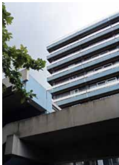
IA und IB stehen vor dem Abriss. Aber zuerst muss saniert werden. Foto: joop
