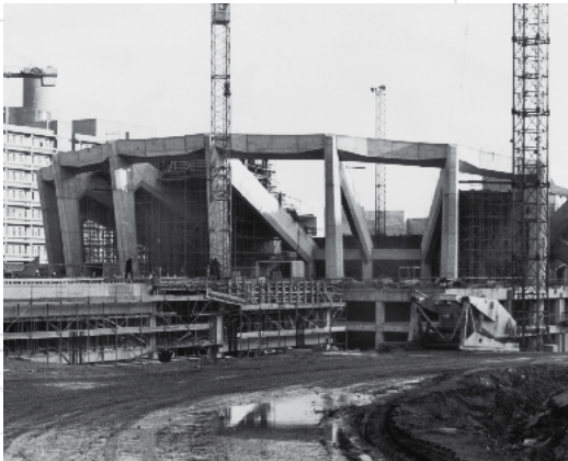
Damals: Bau des Audimax, Aufnahme '72.
