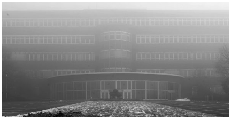
Bald nicht mehr so gespenstisch: Auf dem Gelände des Opelwerks 1 lässt sich demnächst das erste Unternehmen nieder.
