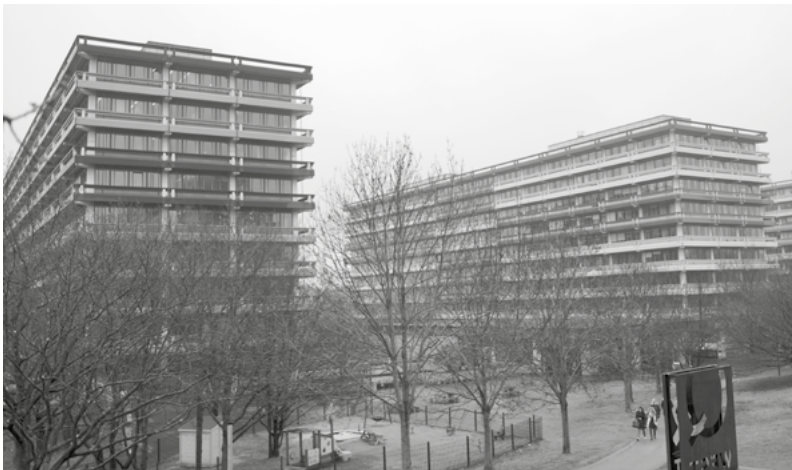
Alte G-Reihe: Hier ist die PCB-Belastung höher als in den neueren Gebäuden. Foto: lor
