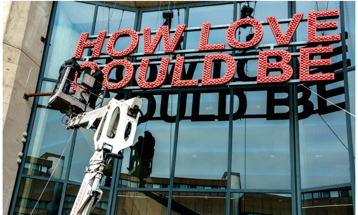
Weg ist das Ding: Der rot erstrahlende Schriftzug zierte fast zwei Jahre das Audimax. Letzten Freitag wurde die Installation von Künstler Tim Etchell abmontiert.
