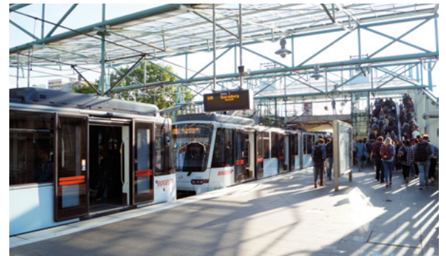
Vorerst nicht nach Langendreer: Ein fehlerhaftes Gutachten verhindert die Verlängerung der U35 zur Unterstraße. Foto: tom
