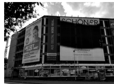
Das Parkhaus P7, bekannt für die Riesenplakate: Bald steht hier das neue Wohnheim samt neuem Parkhaus. Bild: kac
