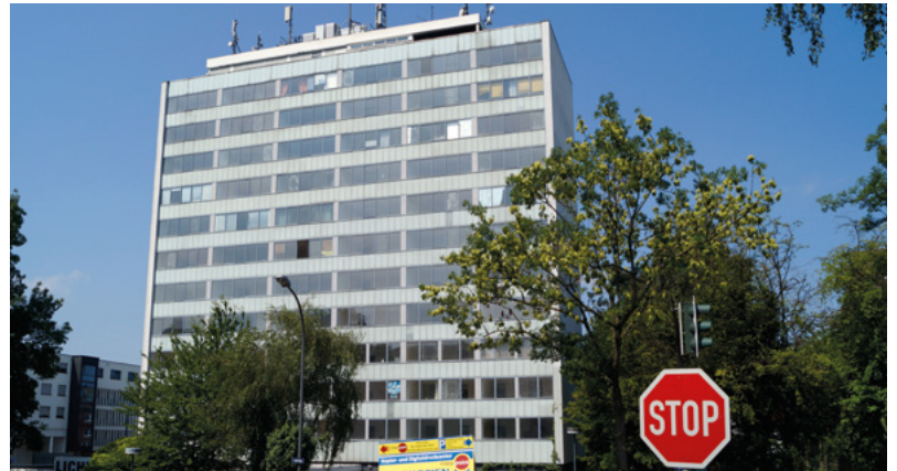
Leer und ohne Glanz: Das evakuierte Lohring-Hochhaus.
