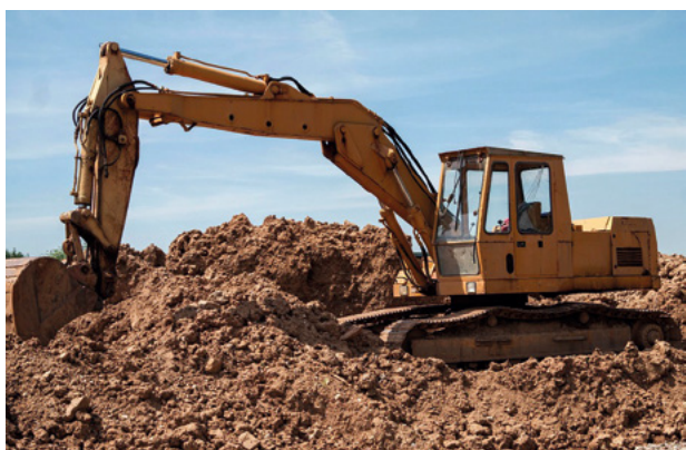
Baustelle in Langendreer: Obwohl die neue Linie ursprünglich 2017 fertig sein sollte, dauert der Bau nun bis 2020.
