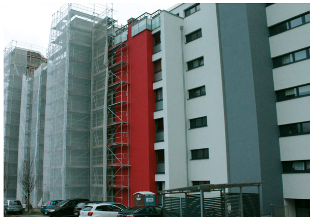
Sanierung des Gebäudekomplex „Am langen Seil“: Die ab 2020 erwarteten Einsparungen durch bessere Dämmung hat die VBW für sich beansprucht.
