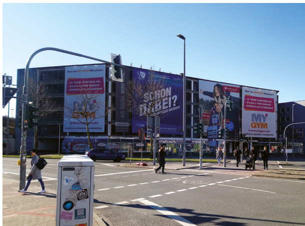
Parkhaus P7: Hier sollte ursprünglich nach Abriss des Gebäudes das Basecamp-Wohnheim entstehen.
