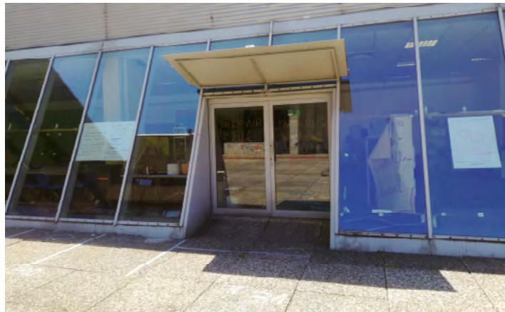
Der Glaskasten an der UB: Hier findet Ihr bald Repair-Café, Fahrradwerkstatt und mehr. Bild: kjan
