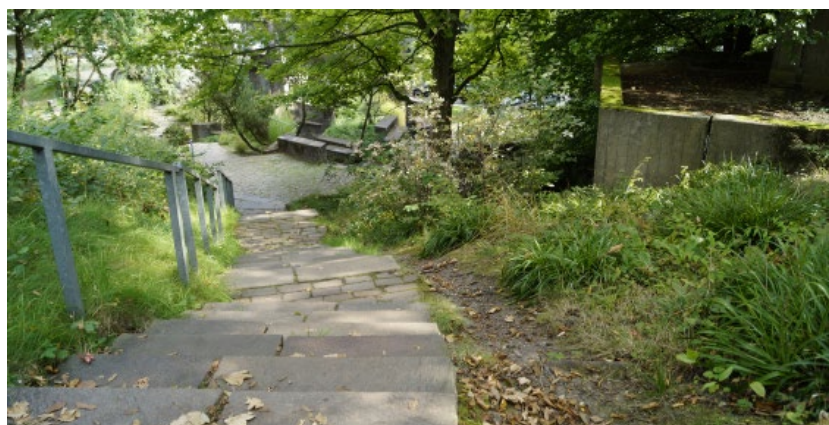
Nach vielen Jahren Stilllegung: Bald soll hier wieder ein künstlicher Bach fließen.
