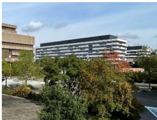
Die I-Gebäudereihe - das Zuhause der Informatik.
